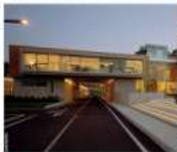
2 IOTTI + PAVARANI ARCHITETTI: DOMUS TECHNICA
